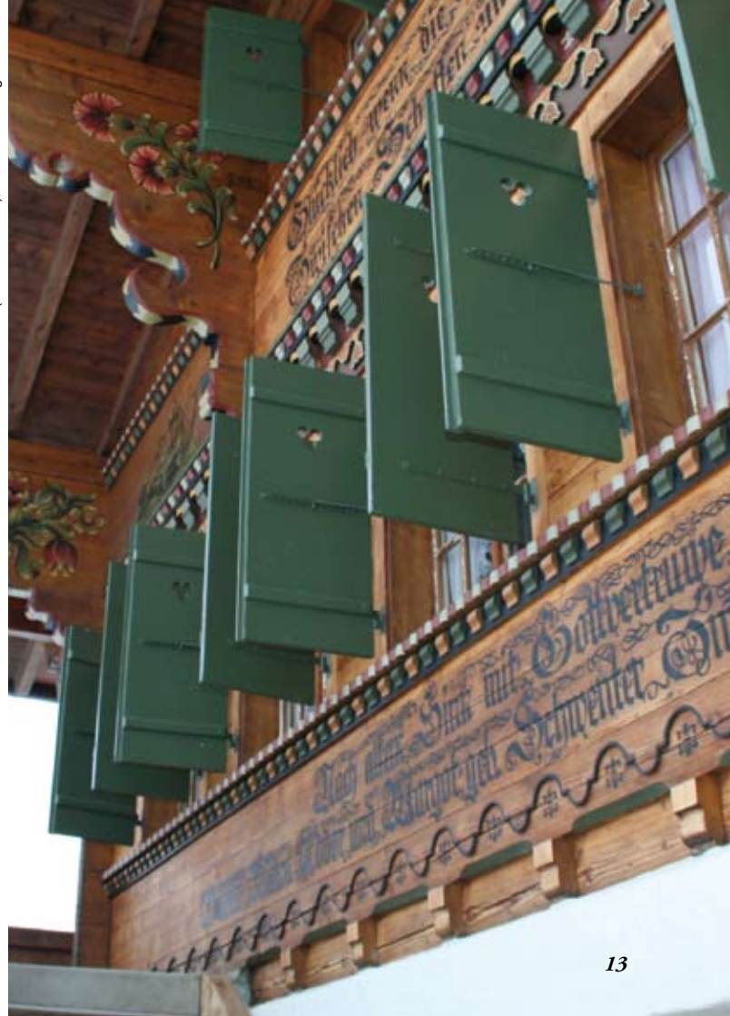
Hausfassade (Berner Oberland); Bild Bärbel Aislinger
